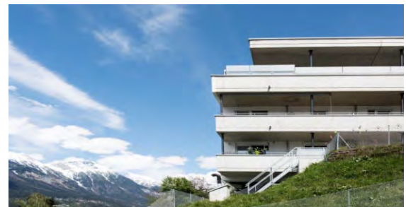
Wohnanlage Felseckstraße, Innsbruck - Mentlberg
