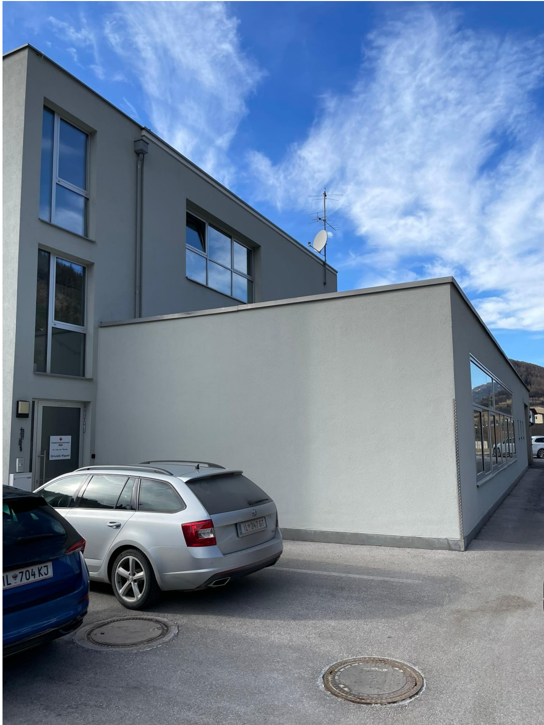
Bild Außenansicht Rückseite
