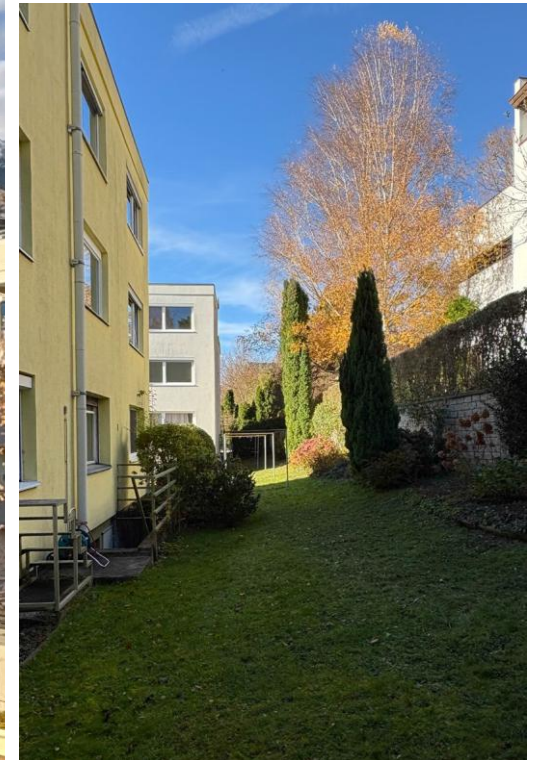
Gesamtanlage: Süden (links) und Norden (oben)
