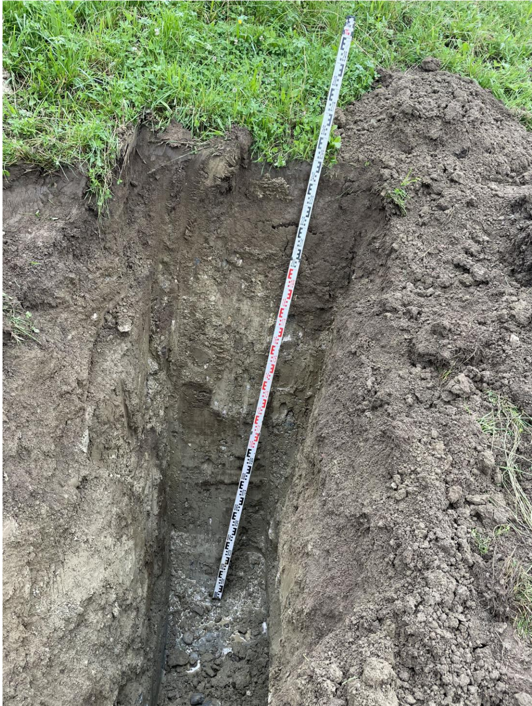
Abb.: Schurf S-02, gesamter Bereich
