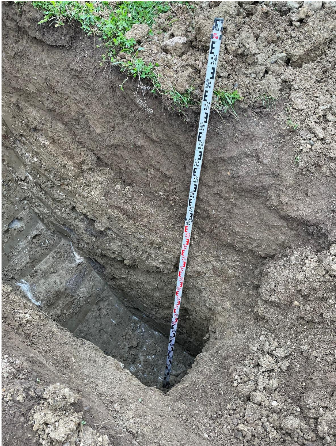
Abb.: Schurf S-04, gesamter Bereich
