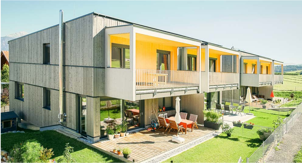
Moderne Holzbauweise in Sistrans.
