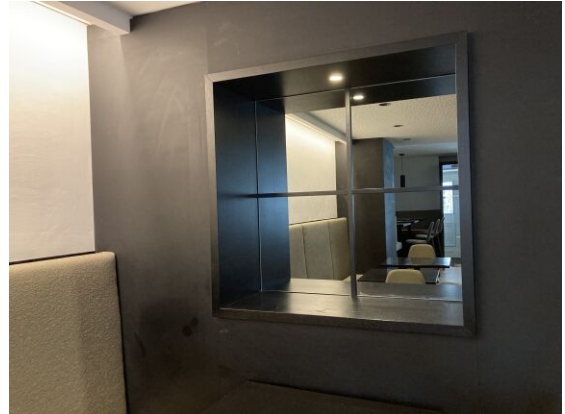
Detail: Innenfenster mit integrierter Beleuchtung
