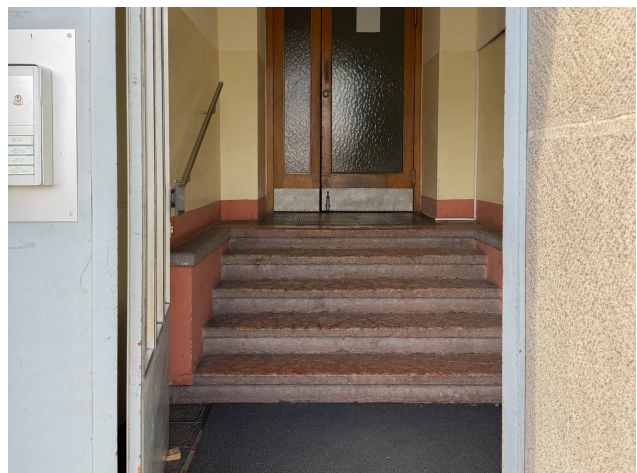
Hauseingang — Zugang über fünf Stufen
