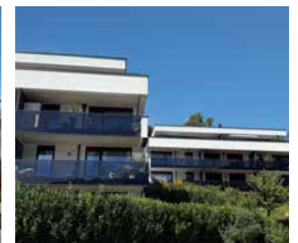
Wohnanlage — Gaisberg Terrassen — Vomp
